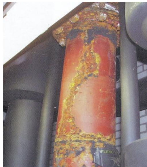
Abb.5 Beispiel: Spannungsrissskorrosion
